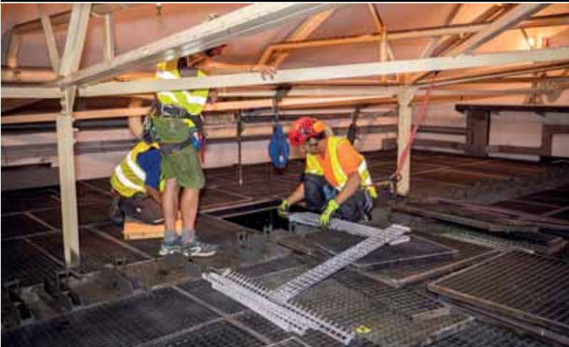
Detail z výměny částí jevištního roštu
