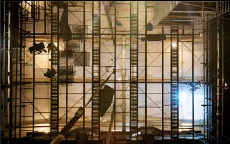
Pohled na jevištní rošt – nejvyšší bod jevištního prostoru
