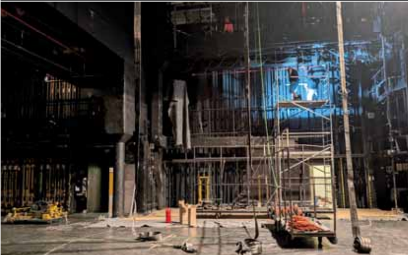
Celkový pohled na pravou stranu jeviště částečně osazenou prvky nové technologie
