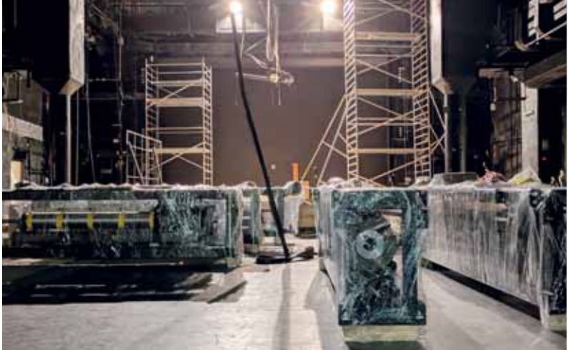
Instalace nové strojní technologie, srpen 2025
