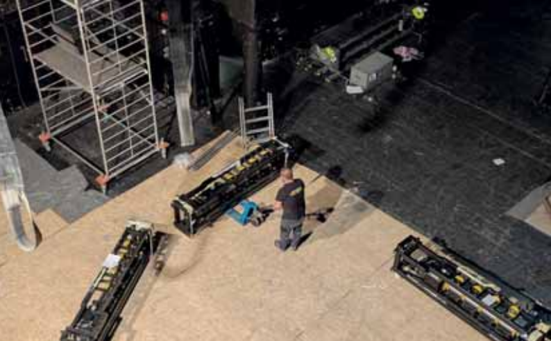
Instalace nové strojní technologie, srpen 2025
