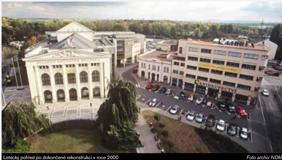
Letecký pohled po dokončené rekonstrukci v roce 2000
